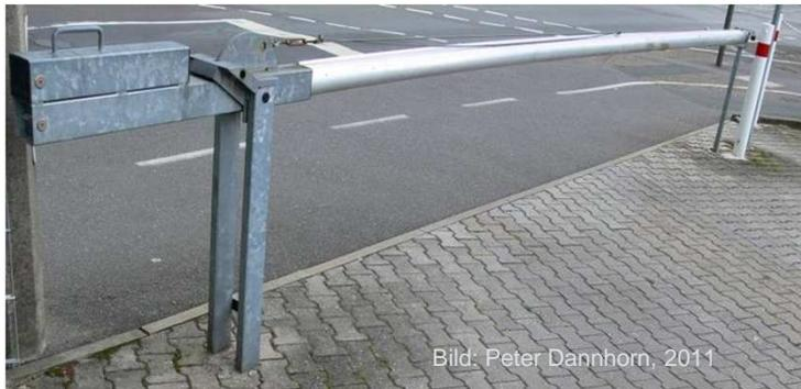
Seit dem Anbringen von Gegenmassen an Schranken, können diese, unabhängig von deren Länge oder Material, mit geringem Kraftaufwand zügig geöffnet bzw. geschlossen werden.
